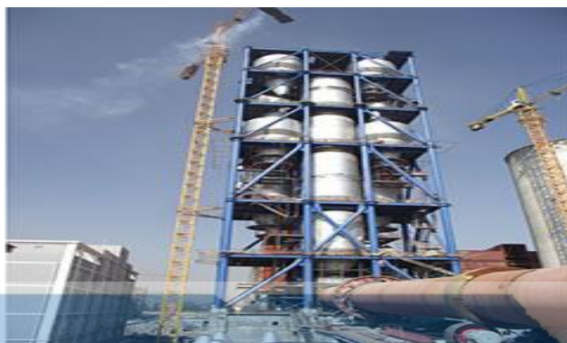
9 Сурет-циклонды жылу алмастырғыштары бар айналмалы пеш
